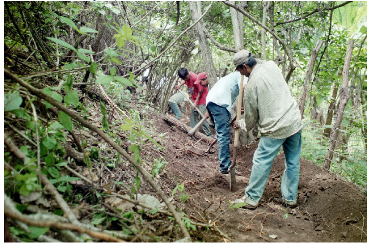
Escarbando zanjas para intercepte el agua superficial.
