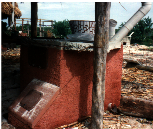
Cámara de baño compostero con silla y tubo de ventilación, dibujo y foto.
