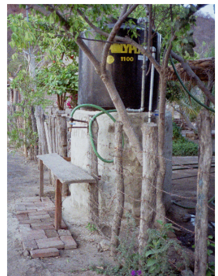
Tinaco con 50 garrafones de agua potable y llave pública
