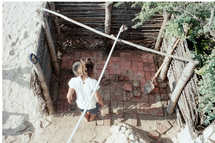
Construyendo una regadera de Teodoro. Muy sencillo, más sano y bonito que las regaderas con paredes y techo de cemento. Esta regadera es las más usada en la playa de los turistas –hasta cien visitantes de la enramada y otros cien a 3 $ cada uno.
