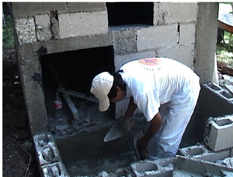
Construyendo un baño compostero.
