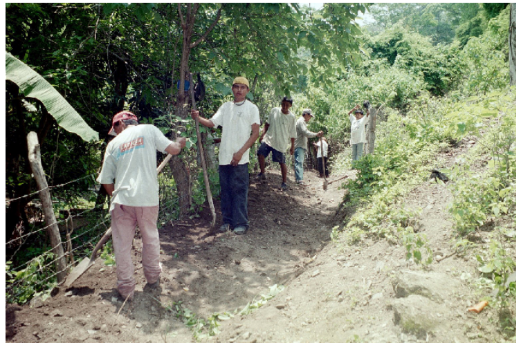
Escarbando zanjas para intercepte el agua superficial.
