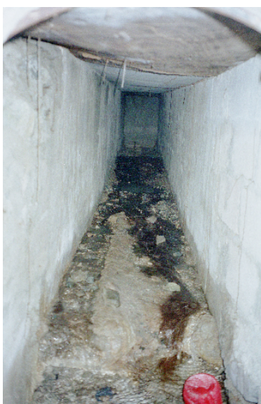
Pared para prevenir la contaminación de la toma de los vecinos con agua superficial
