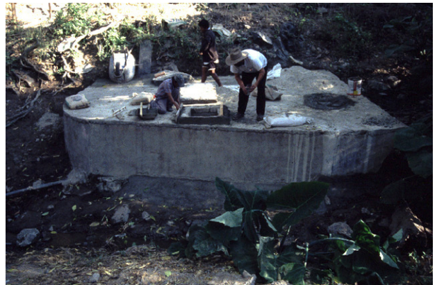
Reparación del depósito viejo.
