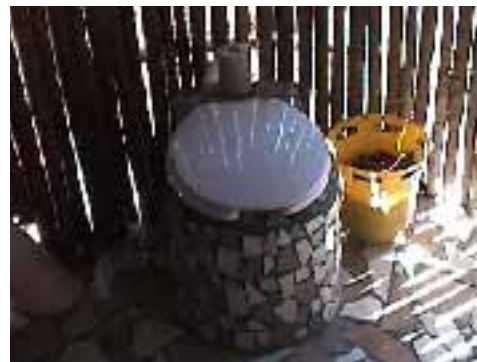
Baño compostero con taza sin agua, en su propia casita.
