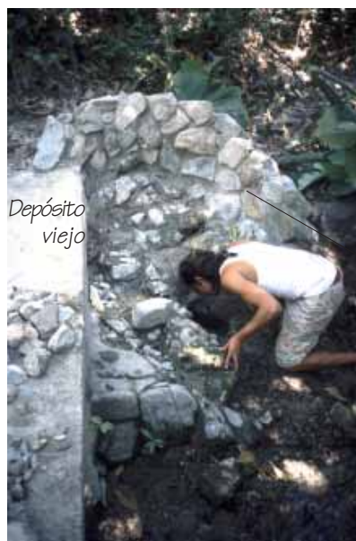
Pared para prevenir la contaminación de la toma de los vecinos con agua superficial
