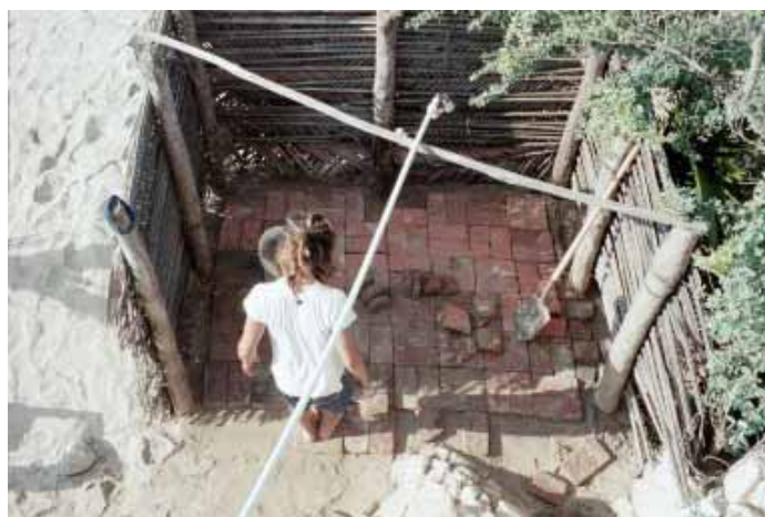
Construyendo una regadera de Teodoro. Muy sencillo, más sano y bonito que las regaderas con paredes y techo de cemento. Esta regadera es la más usada en la playa de los turistas —hasta cien visitantes de la enramada y otros cien a 3 $ cada uno.
