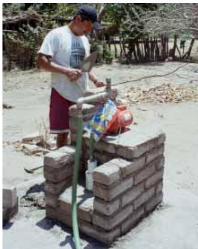
Noria bien cerrada arriba, con barro y cemento
