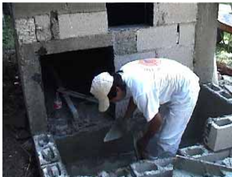
Construyendo un baño compostero.
