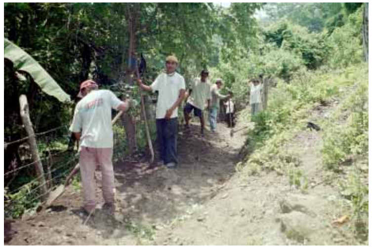
Escarbando zanjas para intercepte el agua superficial.
