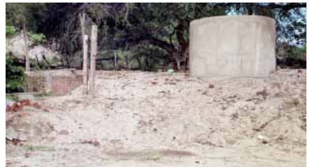
Los pozos profundos dos (izquierda) y tres (derecha)
