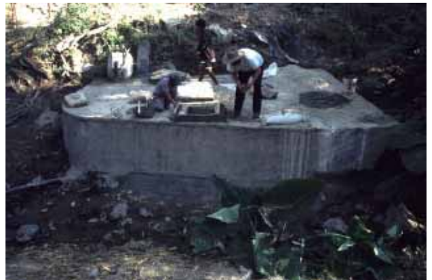
Reparación del depósito viejo.
