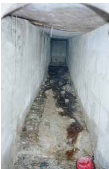
Depósito nuevo, interior
