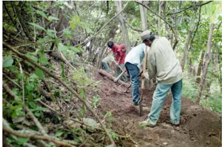
Escarbando zanjas para intercepte el agua superficial.
